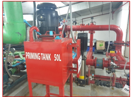
รูปที่ 26 Mian Fire Pump และ Jacky
